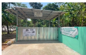
Gambar 3: Pekerjaan Akhir Bangunan TPS3R (Finishing)
