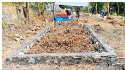
Gambar 1: Pekerjaan Pondasi Bangunan TPS3R
