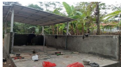
Gambar 2: Pekerjaan Dinding dan Rangka Atap TPS3R
